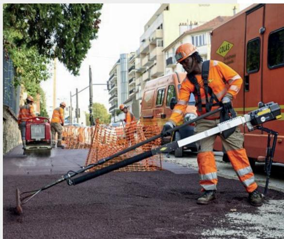
Figure 1 : Utilisation du râteau « cobotisé » ExoPush de Colas pour mettre en œuvre manuellement l'enrobé sur la chaussée
