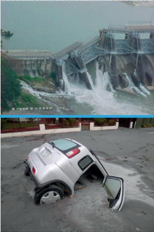
Figure 1 : Exemples de conséquences dues au phénomène de liquéfaction du sol
