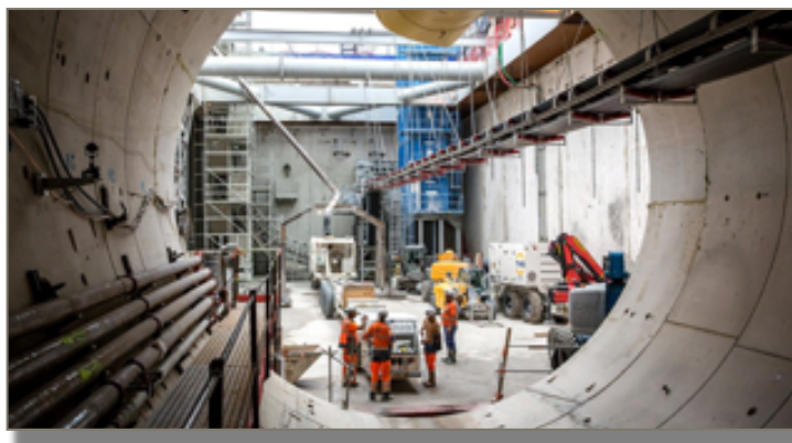
NGE est membre du groupement Alliance (NGE, Demathieu Bard - mandataire -, Implenia et Impresa Pizzarotti) réalisant le tronçon « T2C » de la ligne 15 Sud du Grand Paris Express. Il est également allié à l'Italien Salini Impregilo pour le deuxième tronçon de la ligne 16, qui sera le premier tunnel de transport français en béton fibré. - Stéphane Bouquet
