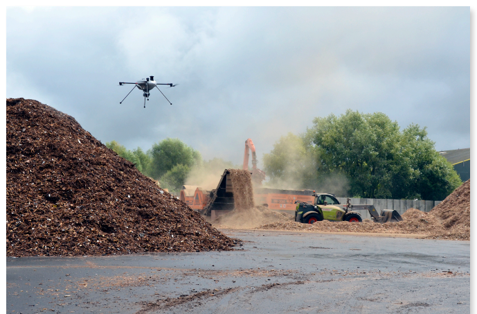
Utilisation des drones dans le domaine du BTP. © M. Hervé Polidor (PDG de POLIDRONE)
