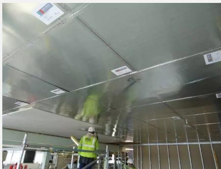
Figure 2 : Panneaux de MCP [6]
